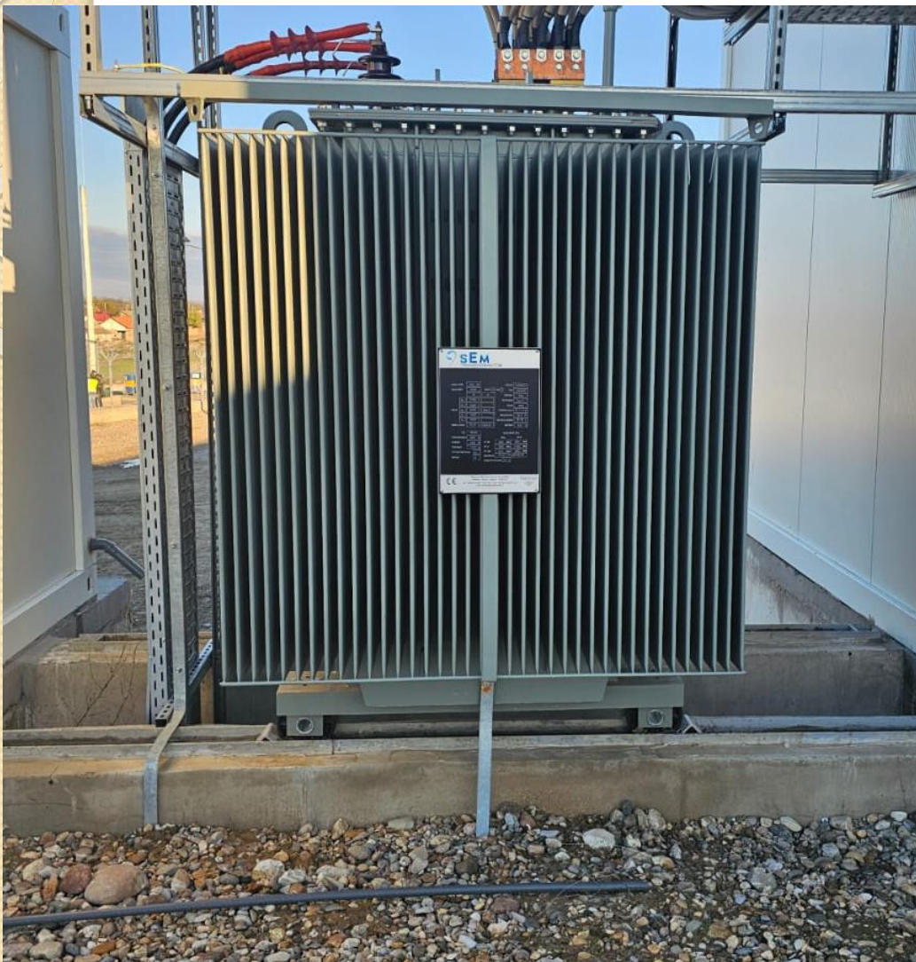
Transformator 0.8/20kV 6300kVA
